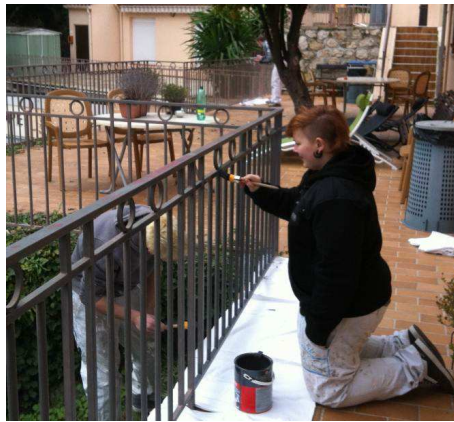
Lackierarbeiten am Geländer. Foto: KBBW.
